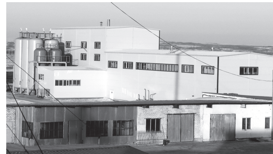
Рисунок 2. Республика Казахстан, Актюбинский район, г. Алга. Очистные сооружения КОС-240.
